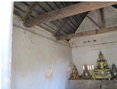
ภาพประกอบ 18 การใช้ผนังรับโครงสร้างส่วนบนหลังคาทั้งหมด คือรสนิยมของช่างฉนวน ตัวอย่างที่วัดศรีบุญเรือง ตำบลพิมาน อำเภอนาแก จังหวัดนครพนม
