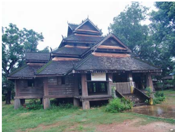
ภาพประกอบ 4 ตัวอย่างโครงสร้างหลังคาเป็นแบบ เบงกาลีที่หอแจกวัดศรีมณฑล ตำบลโพธิ์ทราย อำเภอมือเหล็ก จังหวัดมุกดาหาร เป็นกลุ่มพ่อค้าจากทางเหนือลงมาสร้างไว้ เมื่อปี พ.ศ. 2480
