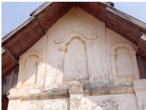
ภาพประกอบ 16 ตัวอย่างการใช้ศิลาแลงเป็นวัสดุหลัก ที่วัดสะพานคำ อำเภอเมือง จังหวัดสกลนคร
