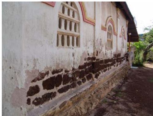
ภาพประกอบ 16 ตัวอย่างการใช้ศิลาแลงเป็นวัสดุหลัก ที่วัดสะพานคำ อำเภอเมือง จังหวัดสกลนคร
