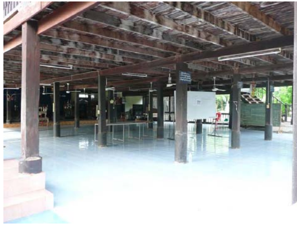
ภาพประกอบ 9 แสดงการยกอาคารให้สูงโดยทำต่อม่อคอนกรีตรับเสาไม้
