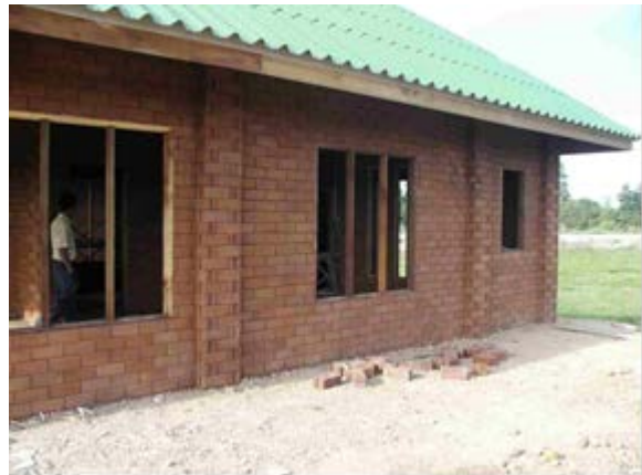
ภาพที่ 2 เทคนิคบล็อกดินอัด (ที่มา: http://www.yimwhan.com )
