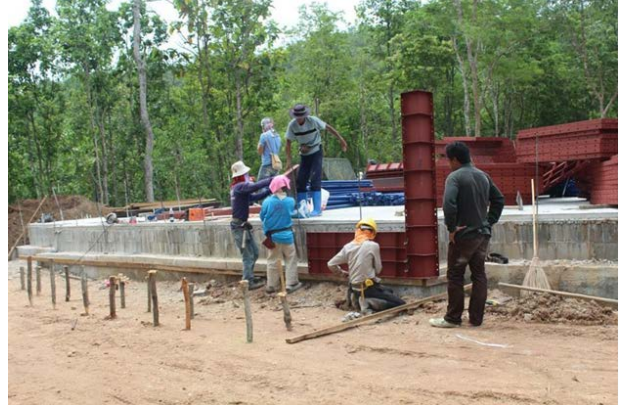
ภาพที่ 9 การเตรียมแม่แบบเหล็ก
